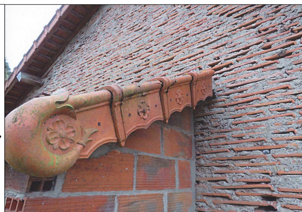
6 - Arêtier élégant en rives d'appentis sur pignon de tuiles mécaniques
