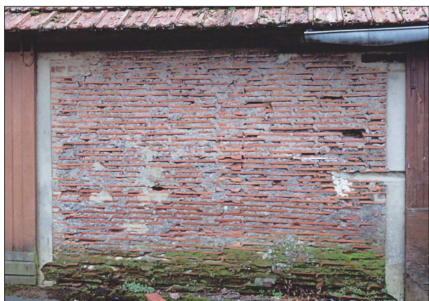
5 - Mur monté en tuiles mécaniques
