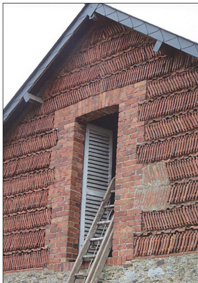
2 - Pignon monté en tuiles placées en arêtes de poisson
