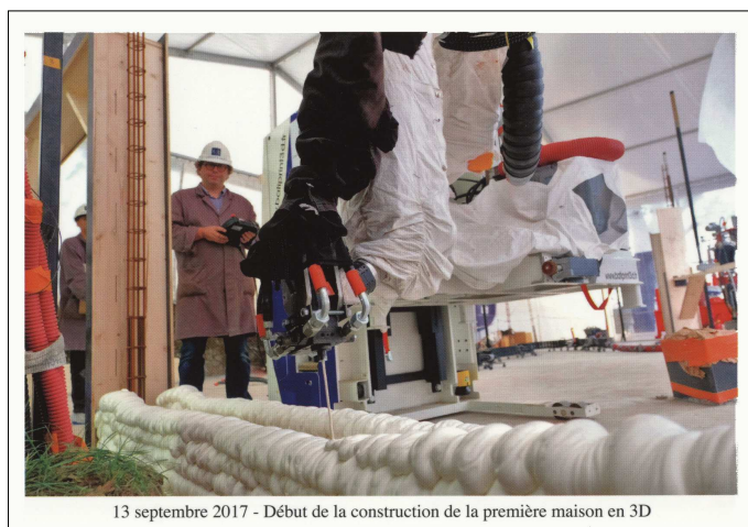
13 septembre 2017 - Début de la construction de la première maison en 3D
